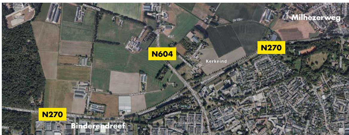
Figuur 3.9 Luchtfoto N270 tussen Binderendreef en Milhezerweg in Walsberg (bron: Cyclomedia)
