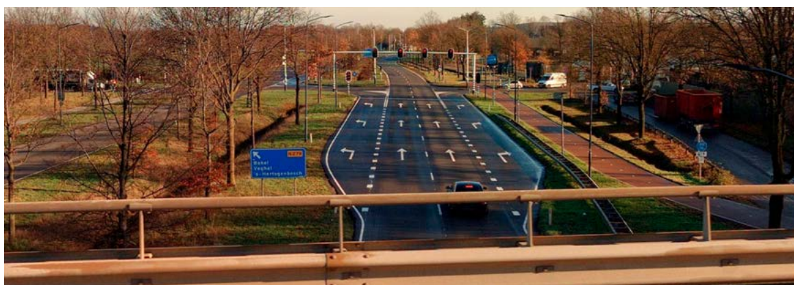
Figuur 3.4 Ongelijkvloerse kruising N279-N270 kijkend richting N270-Walsberg (bron: Cyclomedia)
