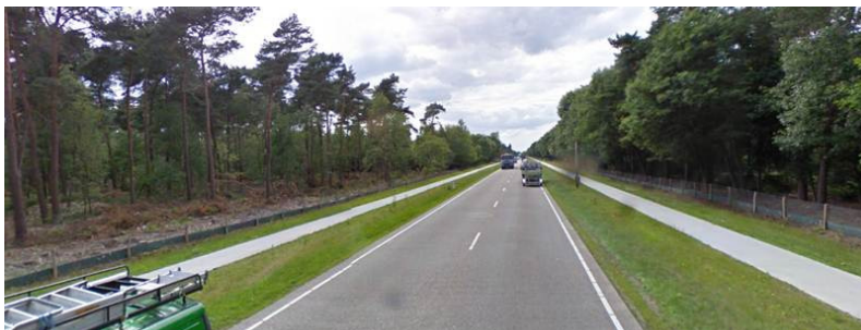
Figuur 4: impressie N270 ter hoogte van bosgebied Zandbos-Brouwhuisse heide met aan weerszijden amfibiescherm en dassenraster.
