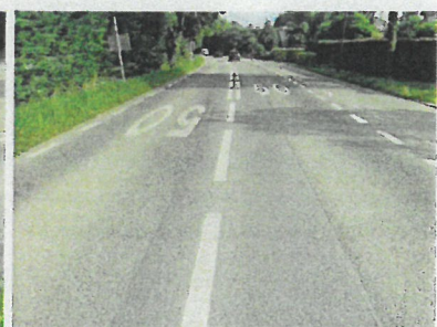
fig.2.4 reparatie middendeel (oostdeel)
