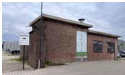
Afbeelding 21. Monumentaal Transformatorhuisje, Donk
