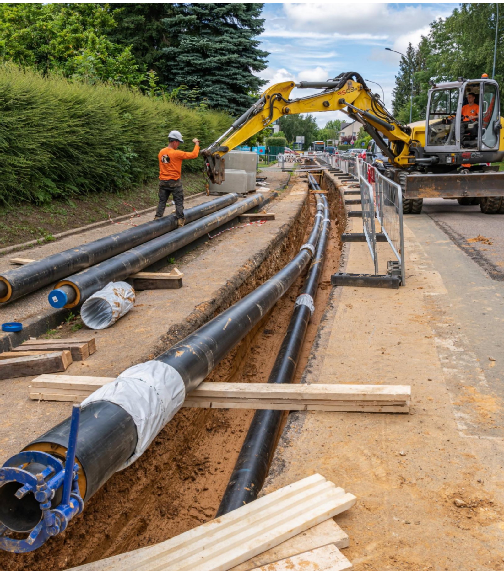
Het proces van het leggen ↑ van een warmtenet.
