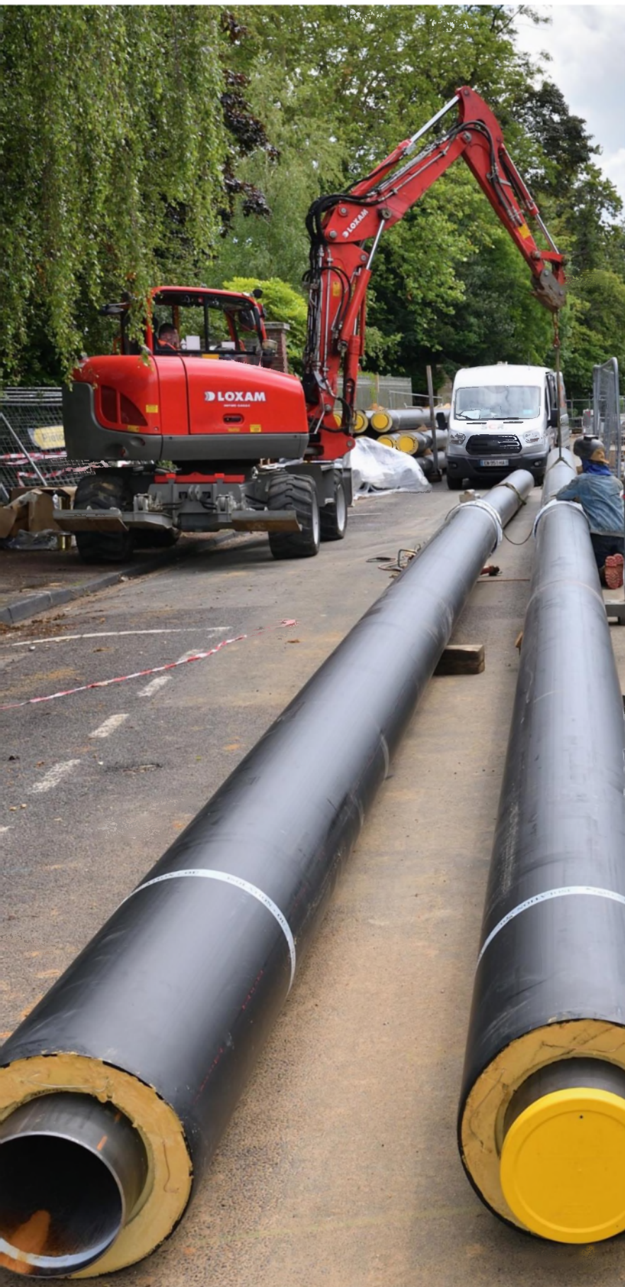
Het proces van het leggen van een warmtenet. ↑
