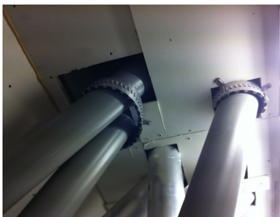
Afbeelding 6: Foutieve poging toepassen brandmanchetten
