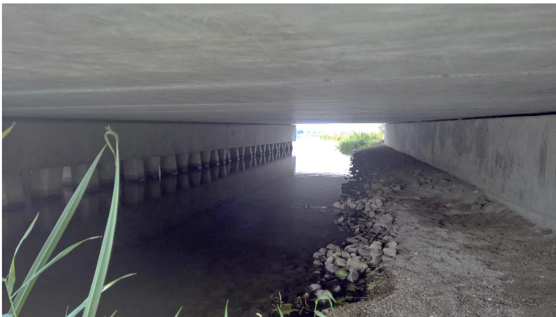
Ontsnippering: doorlopende oever langs de Hertogswetering onder de A50 bij Herpen
