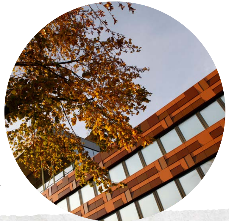
Zonnepanelen in gevel, Kuijpers Helmond Foto: Bjorn Vijlbrief
